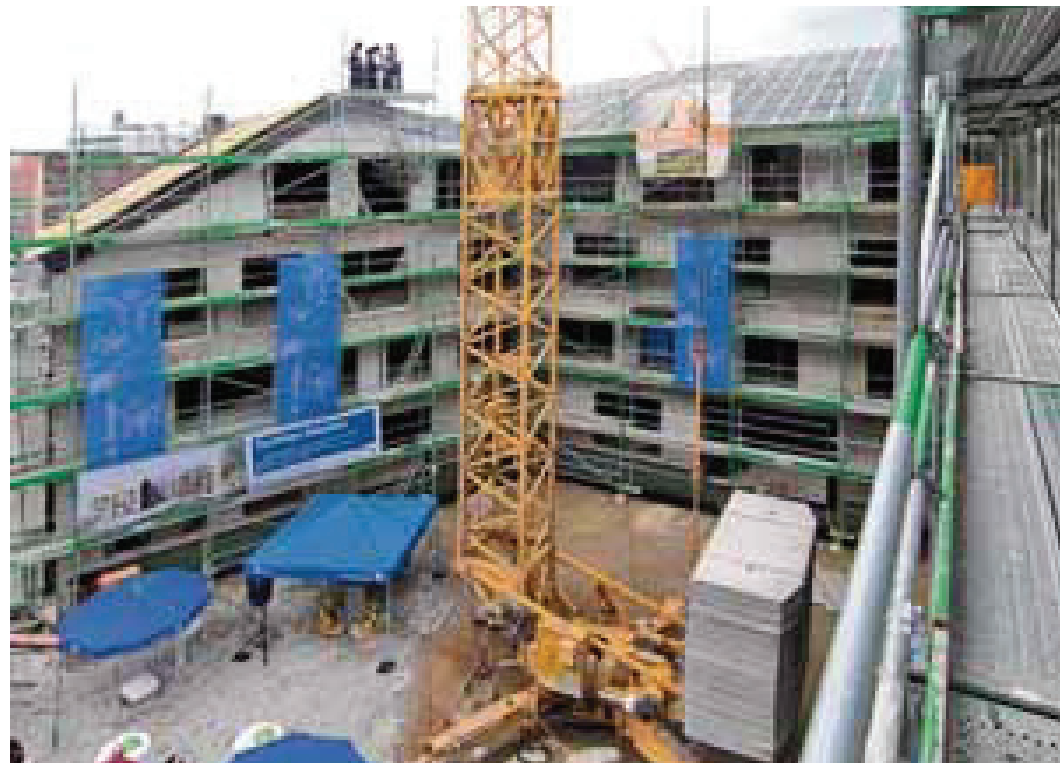
Richtfest wurde am Freitag gefeiert für das Passivhaus-Kompetenzzentrum auf dem Schwanengelände.
