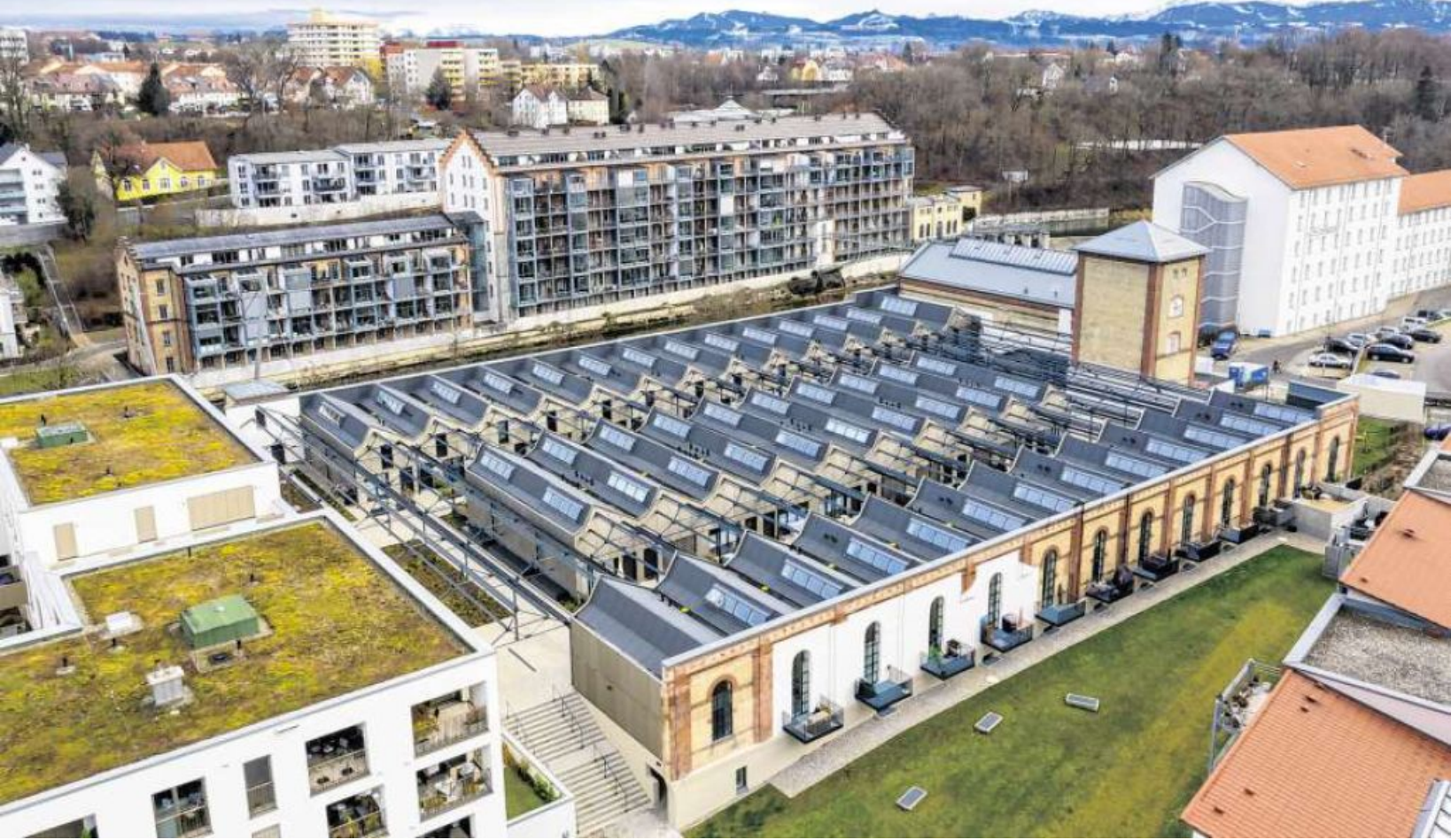
Für die Sanierung markanter Gebäude der ehemaligen Spinnerei & Weberei an der Iller erhielt die Sozialbau Kempten mehrere Auszeichnungen – im Fokus stand dabei unter anderem die Sheddachhalle (im Vordergrund) mit ihrer Klinkerfassade und dem namensgebenden Sägezahndach. Foto: Ralf Lienert
