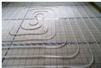
Die Leitungsschlangen der Fußbodenheizung sind schon verlegt.
