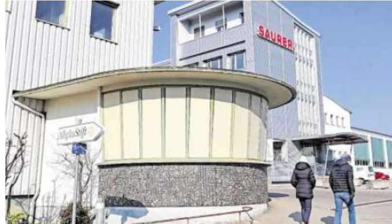
Teile des Bestands auf dem ehemaligen Saurer-Allma-Gelände will die Sozialbau erhalten, wie zum Beispiel dieses Pförtnerhäuschen. Foto: Martina Diemand
