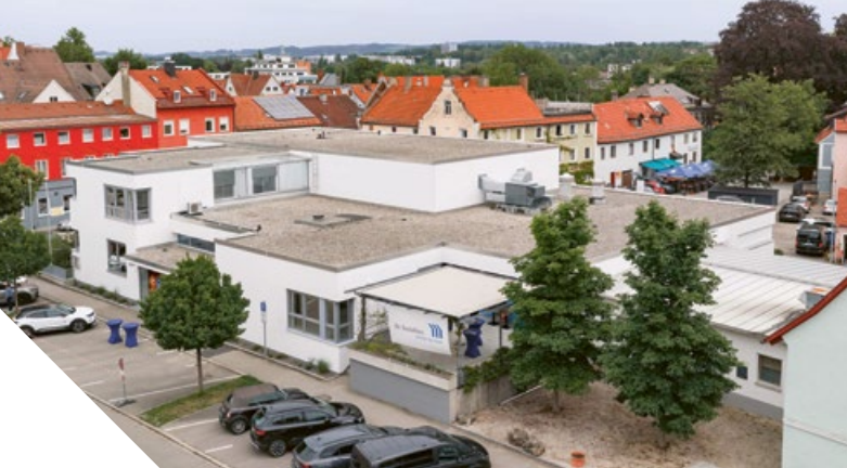
Umbau Haus Hochland für die Montessori Fachoberschule
