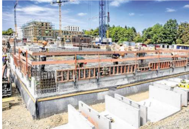
Derzeit entsteht das neue Versorgungszentrum in der Parkstadt Engelhalde. Im Jahr 2028 soll dort ein Netto-Markt einziehen. Foto: Ralf Lienert
